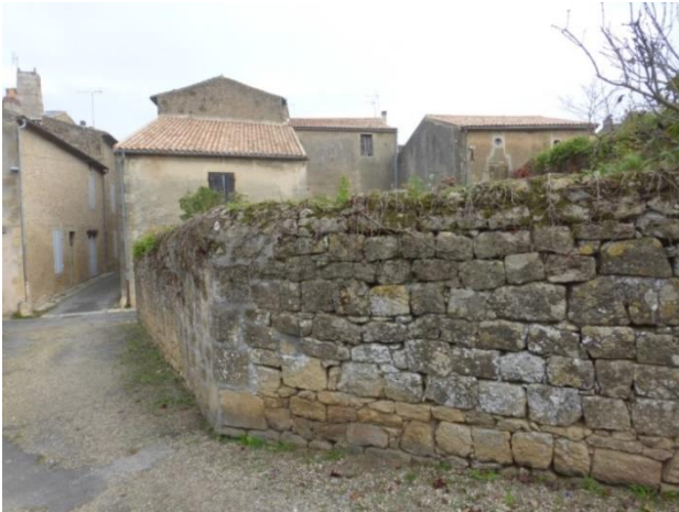
Mur de clôture de jardin, maçonnerie de moellons assisés, couronnement en bâtière.
