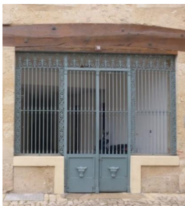
Ancienne baie de devanture en feuillure, fermée par une grille.
