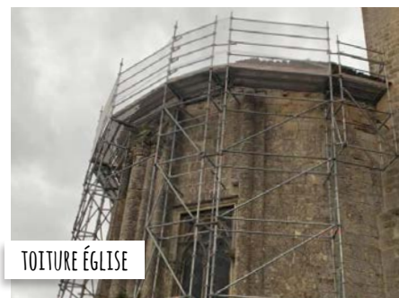
TOITURES BÂTIMENTS COMMUNAUX
