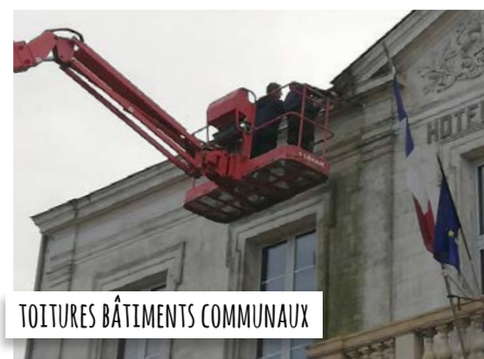
ENTRETIEN PETIT BÂTI
