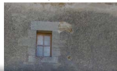
Changer les fenêtres
